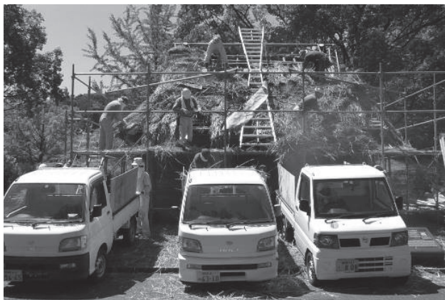
屋根解体作業
