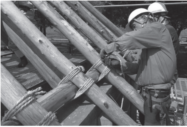
縄による組立て作業
