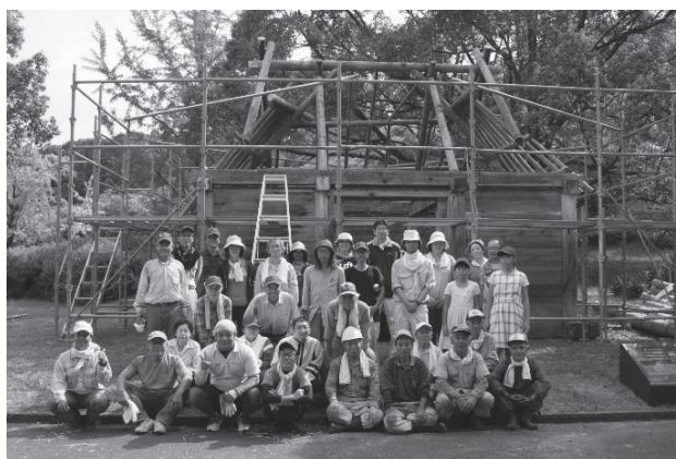
屋根の解体完了
