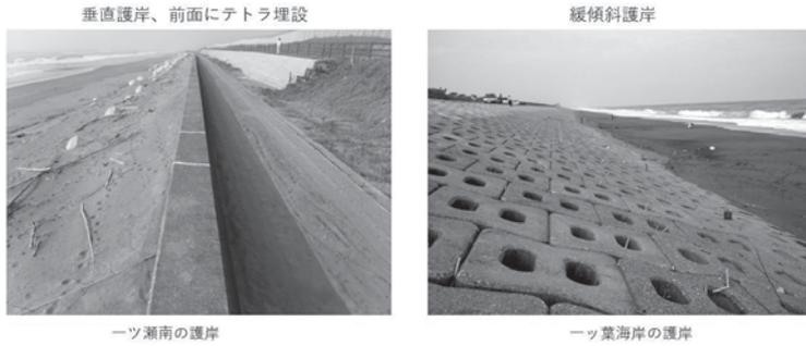
図11 宮崎市海岸に建設されている護岸の写真(左、垂直護岸+テトラ; 右、緩傾斜護岸)
