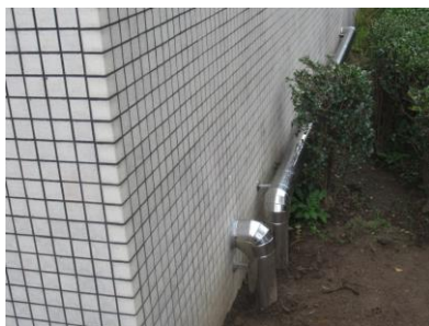
給水管にステンレス製のカバーを装着
